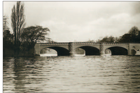
Fritz Schumacher, Krugkoppelbrücke Außenalster Hamburg Foto: Koopmann, 1929
