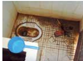
Ecosan (Trockentrenntoilette) in der Republik Moldau
