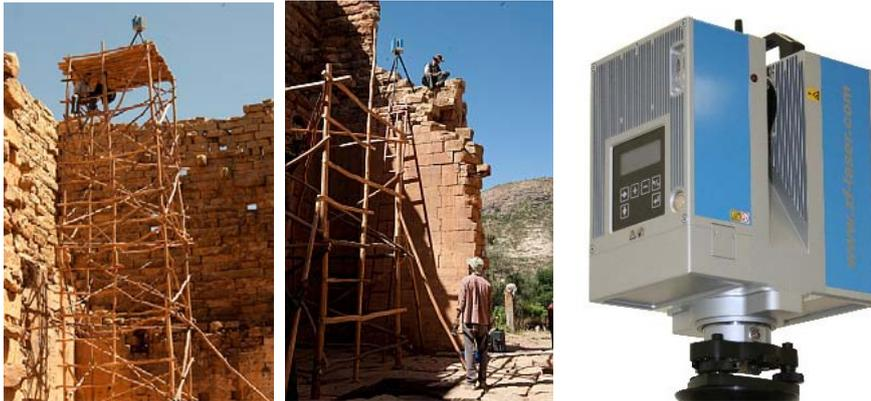
Eingesetzter Laserscanner Imager 5006 von Zoller + Fröhlich (rechts) auf Gerüstturm (links) und auf der Tempelmauer (Mitte)
