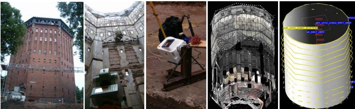
Wasserturm Sternschanze Hamburg, v.l.n.r.: Außenansicht, Innenansicht, Scanner GS100 im Spezialstativ auf der Turmgrundebene, farbcodierte Punktwolke des Innenturms, Teilpunktwolke (Geschoßebenen, in gelbe Linien) des Wasserturms mit eingepasster Sollgeometrie (grauer Zylinder)
