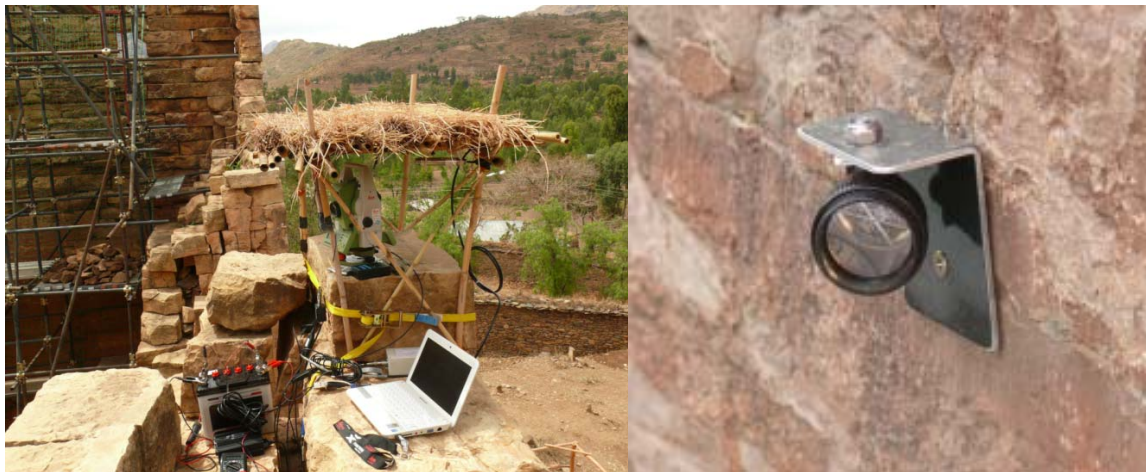
Installiertes Monitoring-System am großen Tempel, signalisierter Punkt in der Tempelwand
