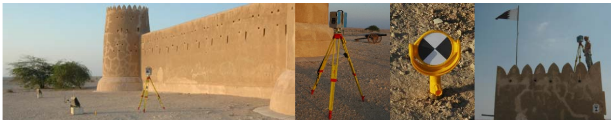
Terrestrischer Laserscanner IMAGER 5006h im Einsatz am Fort Al Zubarah
