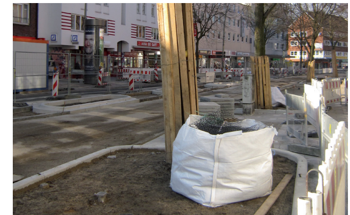
Straßenumbaumaßnahmen in Hamburg / Osterstraße, Foto: Annika Winkelmann
