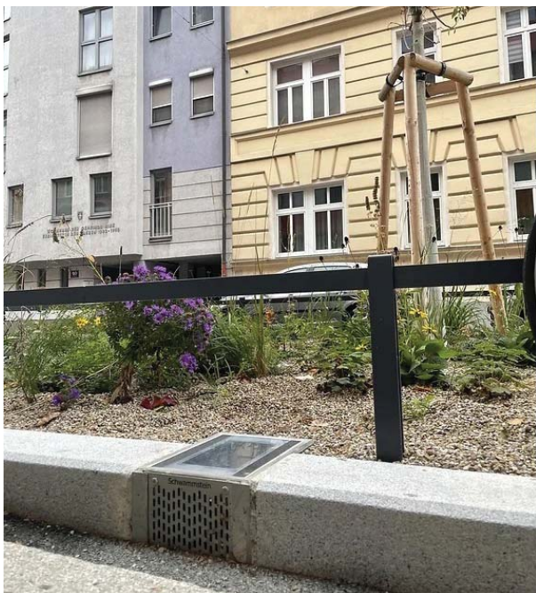
Abb.: 104 Beispiel eines aktiven automatisierten Systems zur Trennung von Sommer- und Winterbetrieb über automatischen Verschluss des Zulaufs über einen Temperatursensor (Foto: www.schwammstein.at ).
