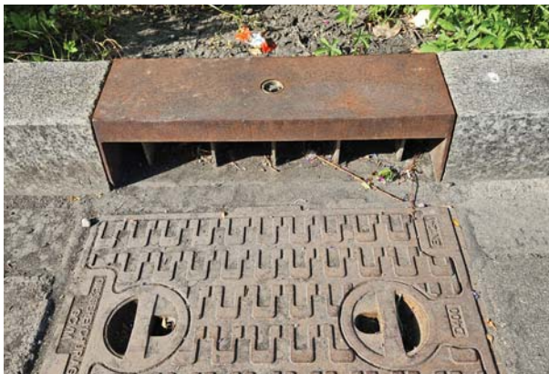
Abb.: 103 Beispiele aktiver manueller Systeme zur Trennung von Sommer- und Winterbetrieb. Links: Einlauf in der Giessereistraße Zürich im Sommerbetrieb (Foto: Michael Richter). Im Winterbetrieb werden die Lamellen geschlossen und das Niederschlagswasser wird in den Straßenablauf geleitet. Rechts: Aufsatz zur Abtrennung Winter-/Sommerbetrieb. Im abgebildeten Zustand wird Niederschlagswasser am Ablauf vorbei in das Pflanzbeet geleitet. Im Winterbetrieb wird der Aufsatz umgedreht und die Abflüsse werden in die Kanalisation geleitet (Foto: DND Landschaftsplanung ZT KG).
