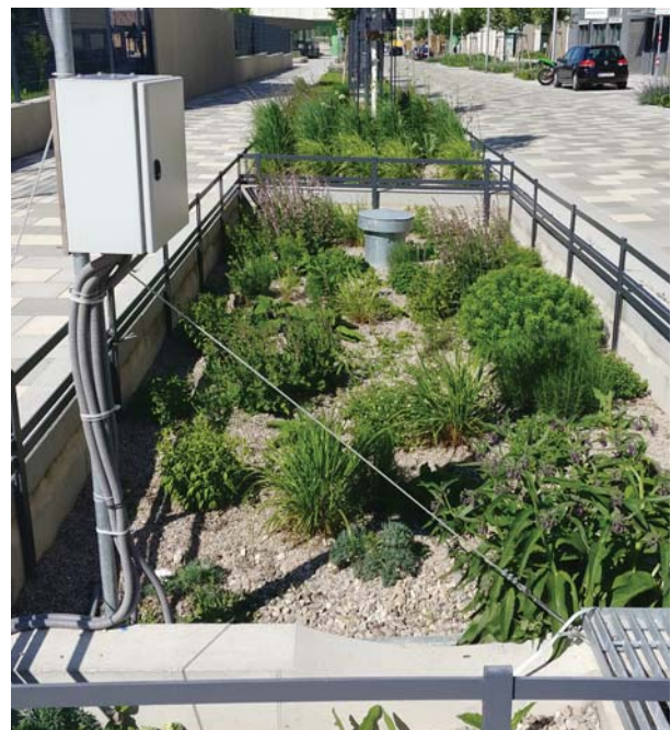
Abb.: 105 Duales Tiefbeet zur Abtrennung von u. a. Tausalz durch Rückstau über Bodenfilter (Foto: Anna Zeiser).
