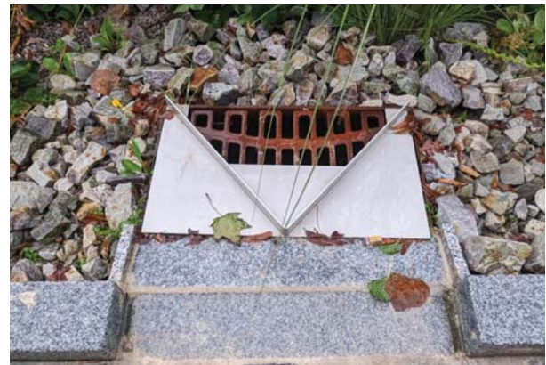
Abb.: 103 Beispiele aktiver manueller Systeme zur Trennung von Sommer- und Winterbetrieb. Links: Einlauf in der Giessereistraße Zürich im Sommerbetrieb (Foto: Michael Richter). Im Winterbetrieb werden die Lamellen geschlossen und das Niederschlagswasser wird in den Straßenablauf geleitet. Rechts: Aufsatz zur Abtrennung Winter-/Sommerbetrieb. Im abgebildeten Zustand wird Niederschlagswasser am Ablauf vorbei in das Pflanzbeet geleitet. Im Winterbetrieb wird der Aufsatz umgedreht und die Abflüsse werden in die Kanalisation geleitet (Foto: DND Landschaftsplanung ZT KG).
