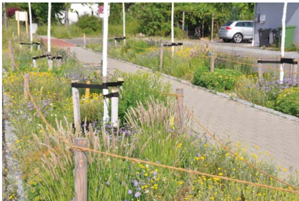
Abb.: 115 Pilotierung von Mulden mit Baumpflanzung in Pfaffenhofen an der Ilm (Patrizia Eben)
