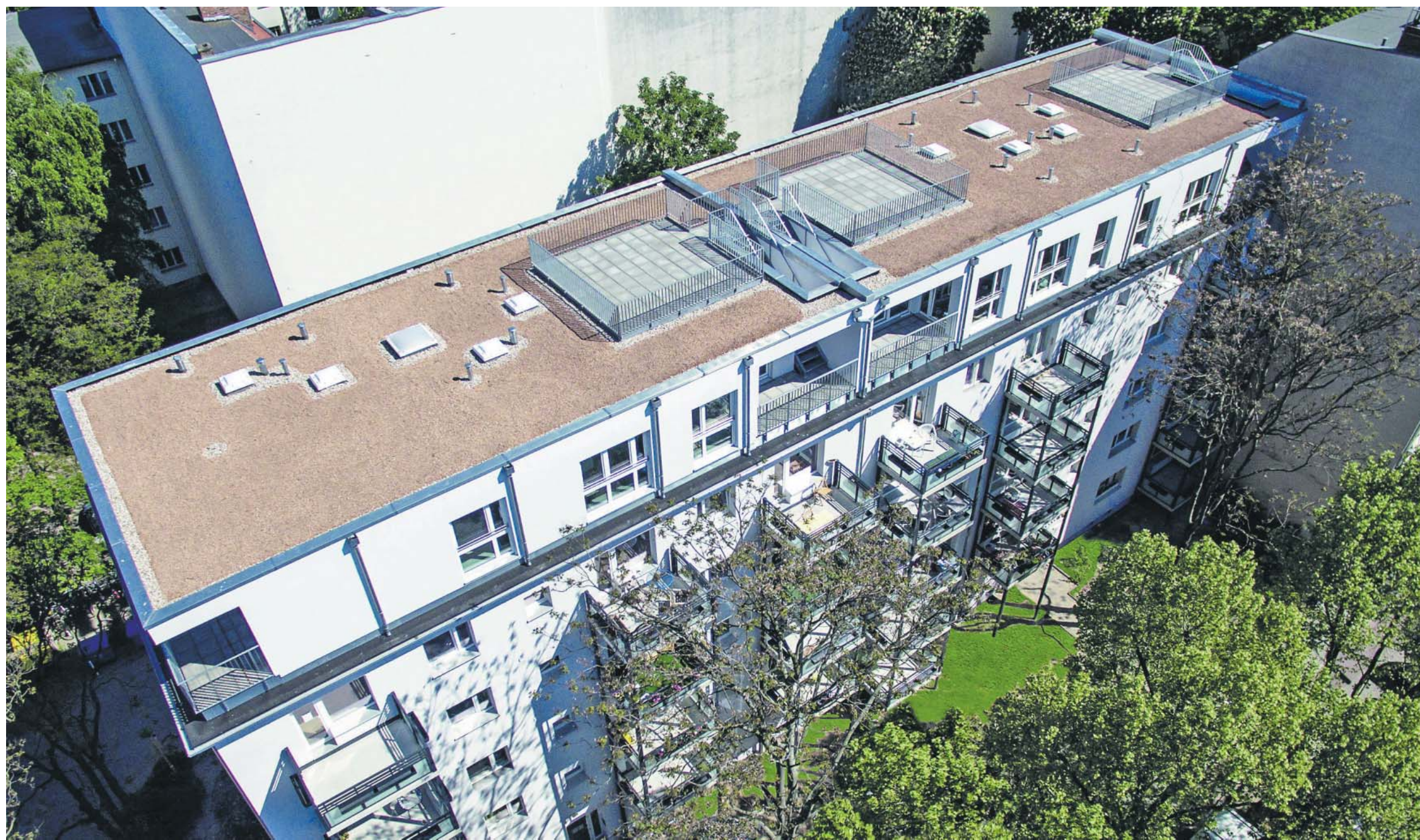
Neu in der Gleditschstraße: Die oberste Etage dieses Wohnhauses in Berlin-Schöneberg ist in Holztafelbauweise entstanden.
