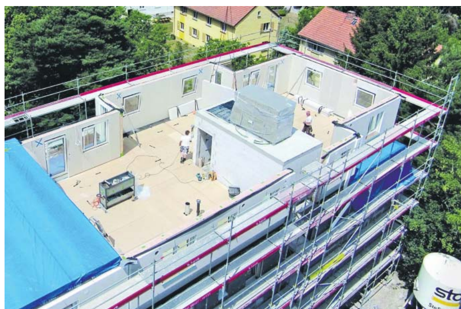
Tür, Fenster und Dämmstoff inklusive: So werden die Elemente verbaut.
