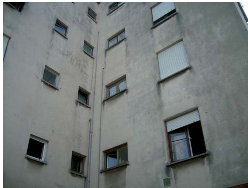
Abbildung 2 : Typische Fassade eines Gebäudes in Zindis. Quelle: Eigene
