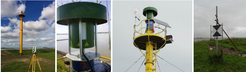
Abb. 2: Komponenten des Messsystems (v.l.n.r.) Messpfeiler, Schutzgehäuse (geschlossen), Plattform des Messpfeilers mit Solarzellen, Windgenerator und Funkantenne, Referenzzielzeichen.
