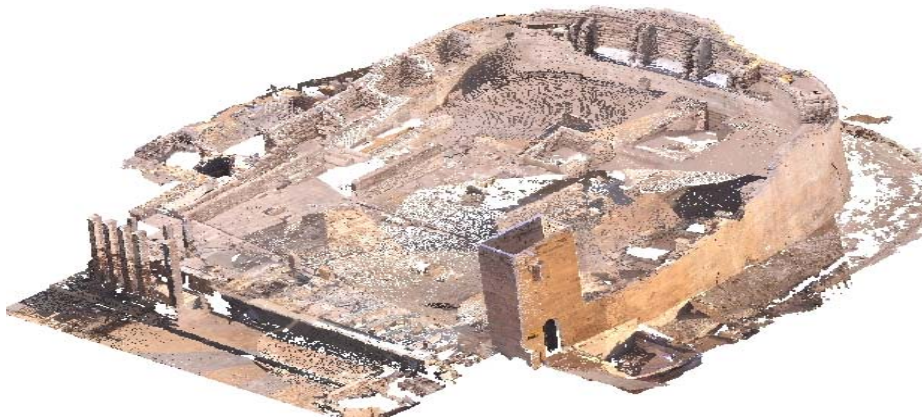
Abb. 3: Gesamtpunktwolke des Almaqah-Tempels nach Georeferenzierung
