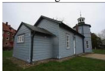
Alter Bahnhof Bergedorf
