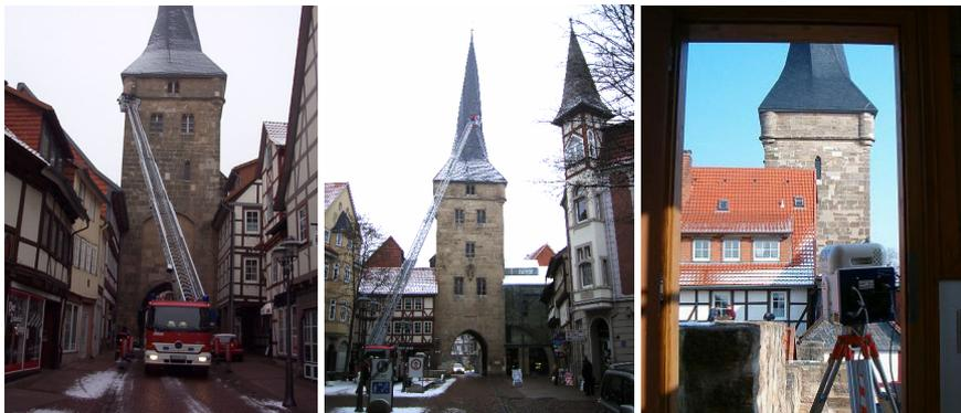
**Abb. 2:** Drehleitereinsatz für Passpunktsignalisierung (links) und photogrammetrische Aufnahme (Mitte), Laserscannerstandpunkt (rechts)
