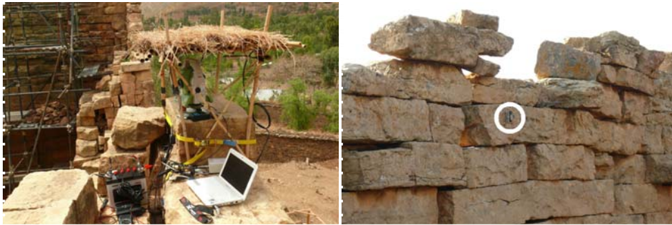
Abb. 5: Monitoringstation Leica GeoMoS (links), Messstelle (Prisma) an oberer Mauerinnenschale (rechts)
