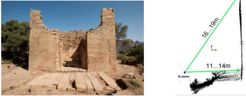
Abb. 2: Der Große Tempel von Yeha in Äthiopien (links) und Aufnahmekonfiguration (rechts)
