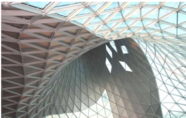
Neue Messe in Mailand; Dachabschnitt und typisierter Knotenanschluss
