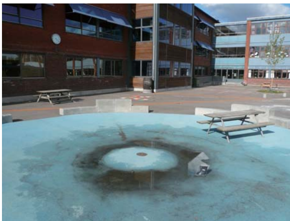
Abb. 08: Kopenhagen Brondby, Brondbyvester Skole, Regensammelfläche mit verzögertem Abfluss
