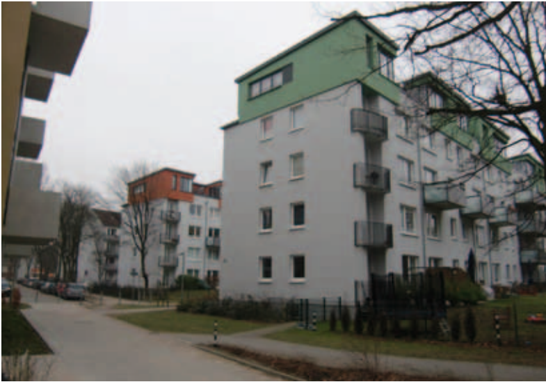
Abbildung 13 Ehemalige Schlichtwohnungen nach der Sanierung
