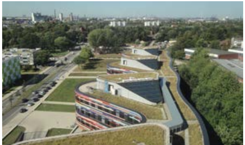
Gründächer der Behörde für Umwelt und Energie in Wilhelmsburg (HCU Hamburg)
