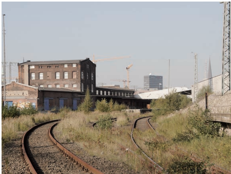
Bahnschuppen und Halle, 2009
