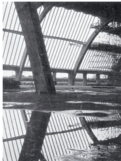
Großmarkthalle im Bau, Innenaufnahme
