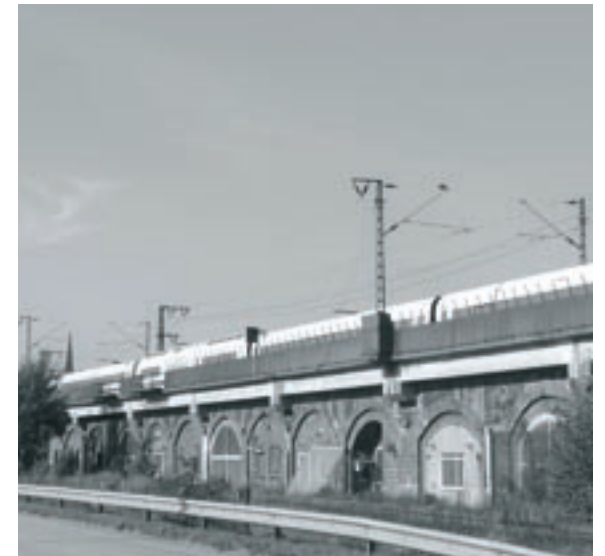
Bahnviadukt am Baakenhafen
