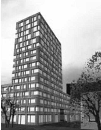
Hochhaus an der Blockecke
